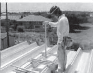
④親綱支柱のセット
