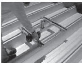
③ハゼ金具をボルト・ナットで固定
